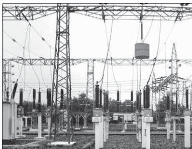
**Gambar 8.16** Unit penurun tegangan listrik PLN yang menyalurkan dan mengatur tegangan listrik dari pusat pembangkit untuk digunakan di perumahan dan perkantoran.
